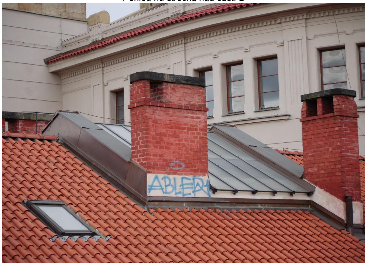
Pohled na střechu nad částí – nový světlík nad schodištěm u části C
