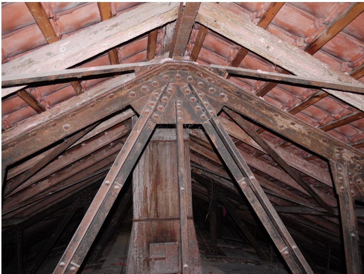
Pohled do krovu nad částí D nad kulturním sálem s klenbou – detail spoje
