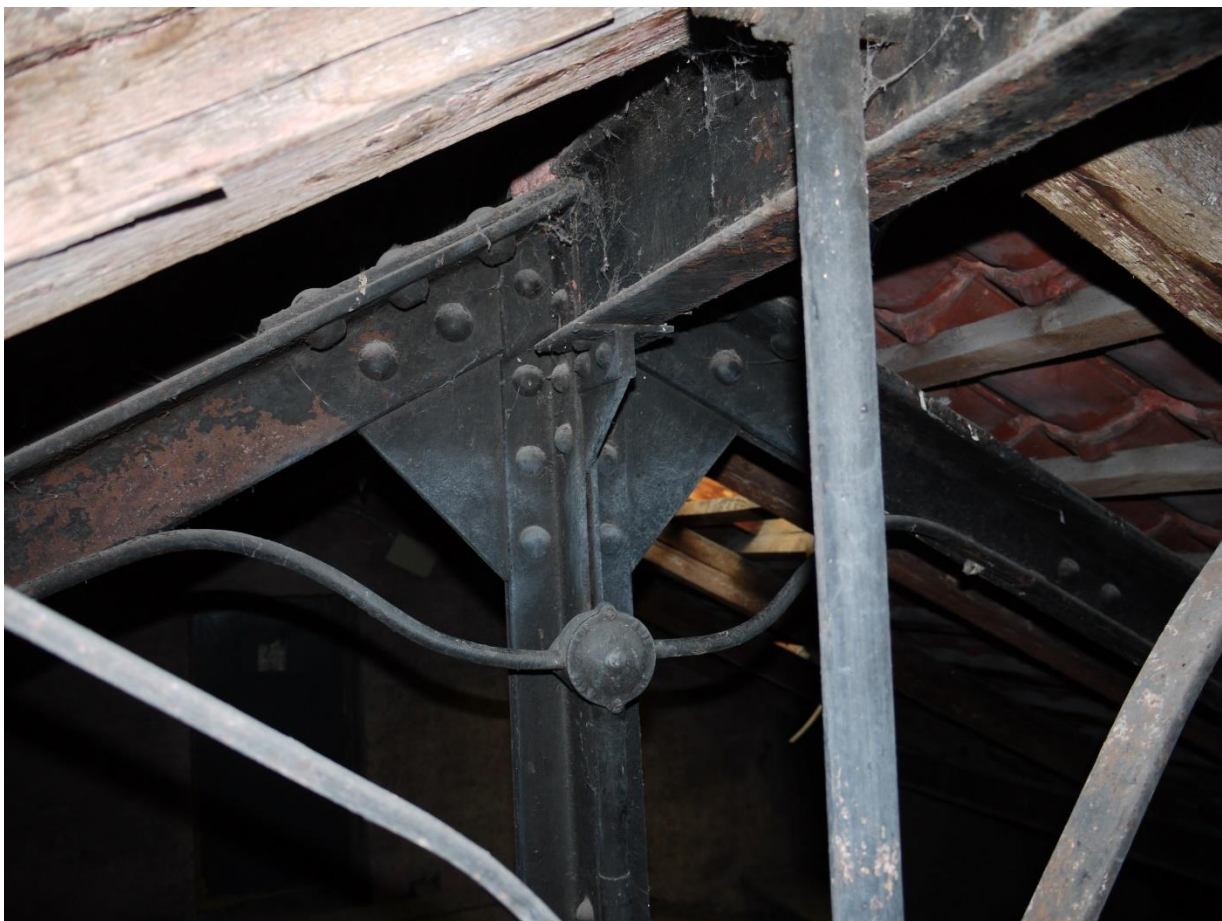
Krov nad částí B s klenbou restaurace - detail spoje
