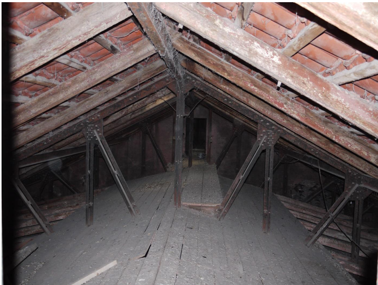
Střední část krovu B nad rovným stropem s vloženou dřevěnou konstrukcí
